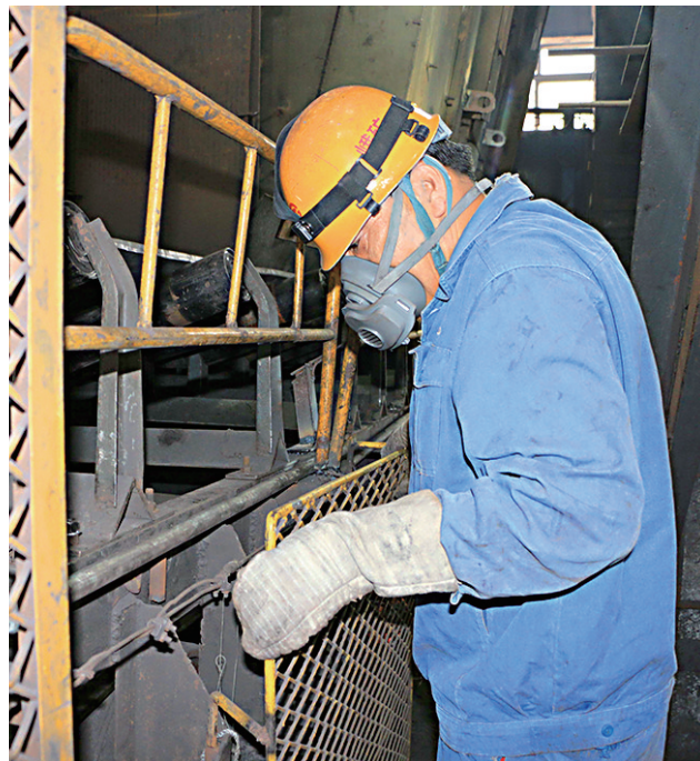
近日,太钢代县矿业公司球团系统进入试车阶段,该公司紧绷安全严格试车弦,详细策划周密部署,坚持试车专人负责把关和登记,加强设备机械性能、技术参数、间隙指标等的试车检测,做到各类问题的预知预判和提前处理,努力实现检修设备百分百合格,确保设备长周期稳定运行。图为焙烧作业区职工正在安装护栏。 赵瑞文 摄
