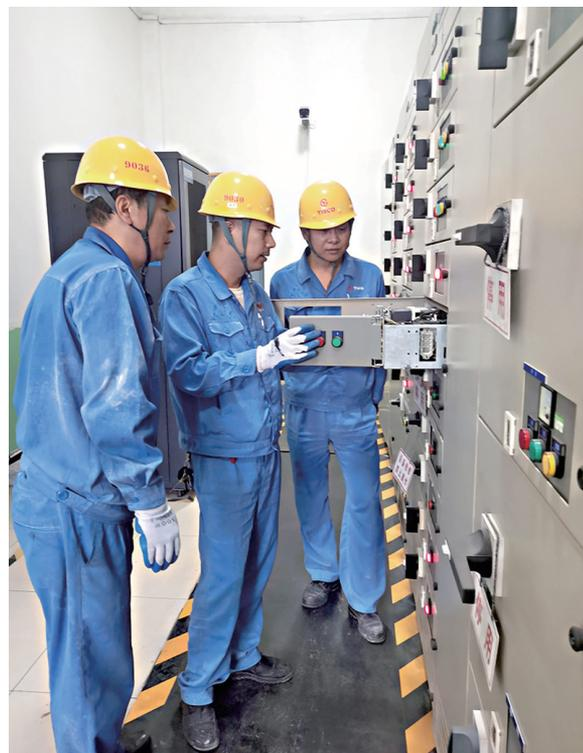
近日,太钢东山矿成品作业区结合公司下发的电气着火事故案例,组织专业人员学习分析,并对辖区电气设备的薄弱线路、电气元件进行排查、更换与整改,确保电气设备正常运行。图为专业人员对皮带电气抽屉柜进行检查整改。 刘玉昌摄
