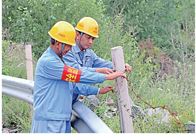
为了杜绝周边村庄及其他外来人员在尾矿库垂钓、游泳、放牧、游玩带来安全风险,太钢代县公司加强针对性管理,在4.5公里的沿途制作各类大型警示标语、播放安全警示宣传录音、增加巡库次数、对损坏的防护设施及时维护,多举措防范风险。图为尾矿作业区人员正在对损坏的铁丝网进行修复。 刘艳云 摄
