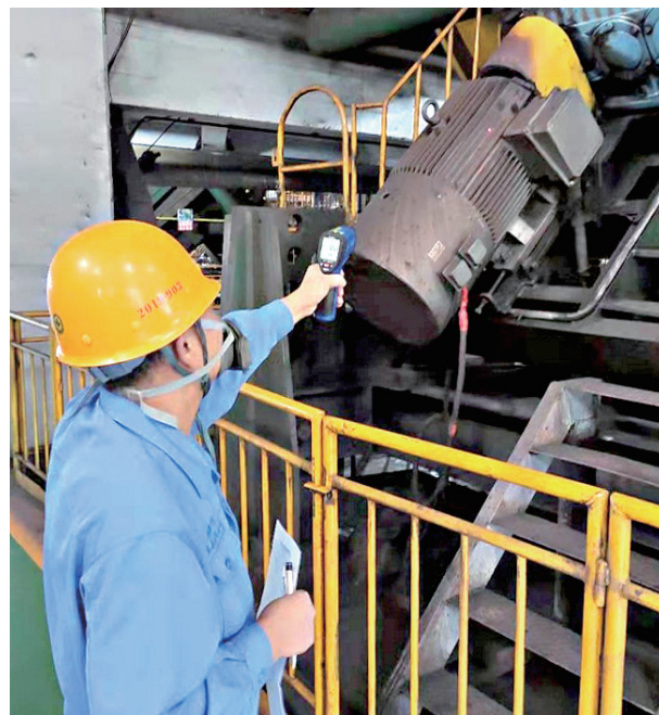
为保证全年生产稳定顺行,太钢岚县矿业公司原料作业区坚持“预防为主”的设备管理理念,成立专业小组开展隐患排查,通过提前预判、提高标准、加强点检等措施,进一步强化设备管理,大力防反事故,保证稳产顺行。 郝伟 摄
