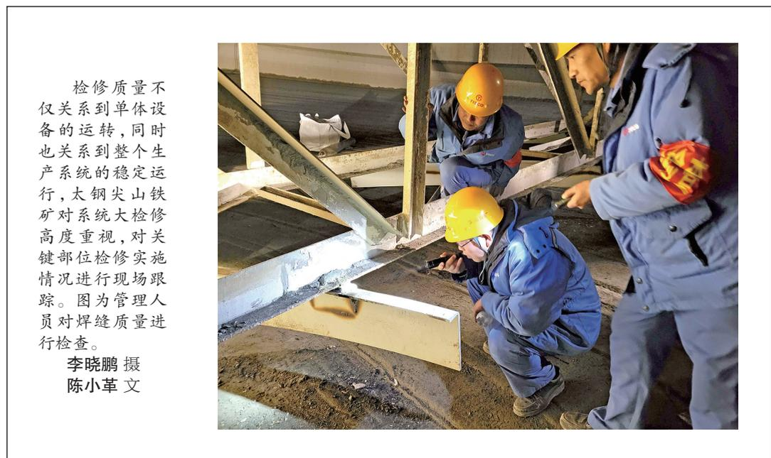
检修质量不仅关系到单体设备的运转,同时也关系到整个生产系统的稳定运行,太钢尖山铁矿对系统大检修高度重视,对关键部位检修实施情况进行现场跟踪。图为管理人员对焊缝质量进行检查。
