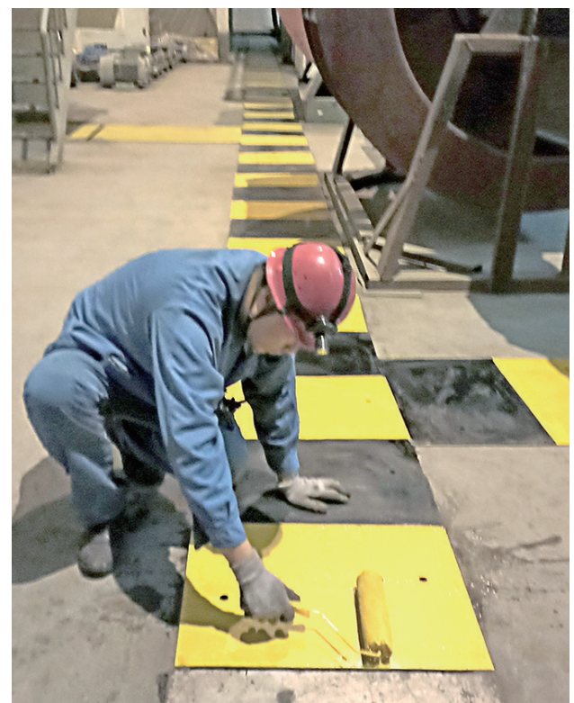
近日,太钢炼铁厂环保作业区对主抽区域电缆井盖进行检查,对盖板进行了标识美化,确保巡检职工和电缆设备安全。图为岗位职工正在对盖板进行防腐标识作业。 李志刚 摄
