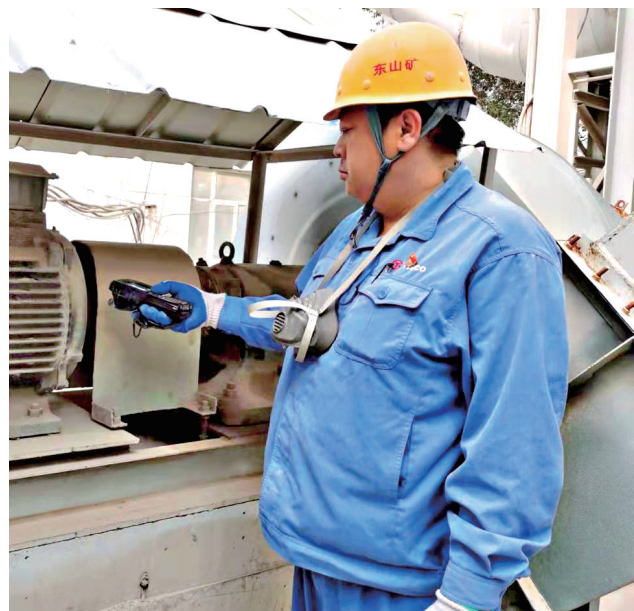
近期气温骤降,太钢东山矿制粉作业区摆磨班加强对设备的巡检作业,对冬季设备运行时可能出现的突发情况进行预测分析,制定应急措施,确保设备安全过冬。图为巡检人员正在对设备进行巡检。 王俊青 摄
