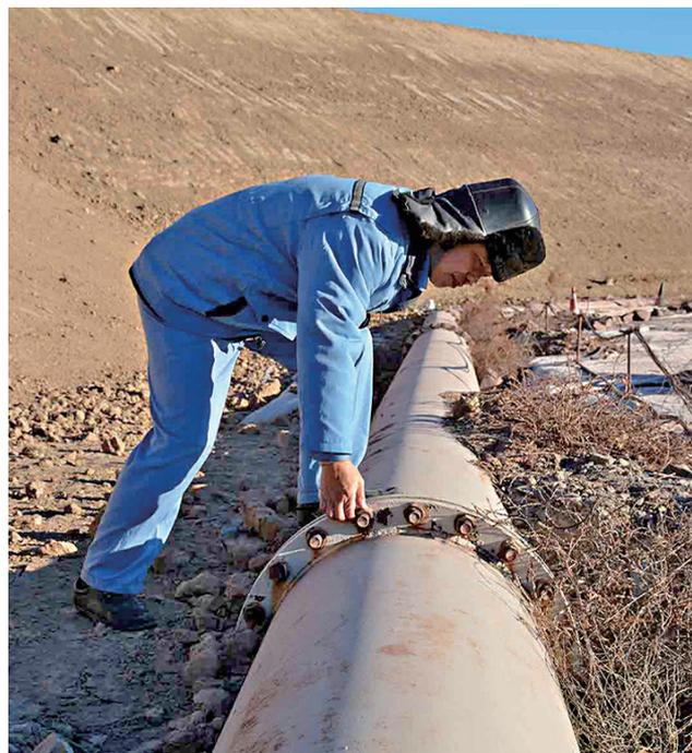
为保证尾矿管道安全运行,太钢岚县矿业公司采矿部近日加大对主管道、伸缩节、镇墩、放矿阀及支管的巡检力度,每个电动阀每半月开关一次,有异常及时反馈、处理,保证尾矿库安全运行。尹军摄
