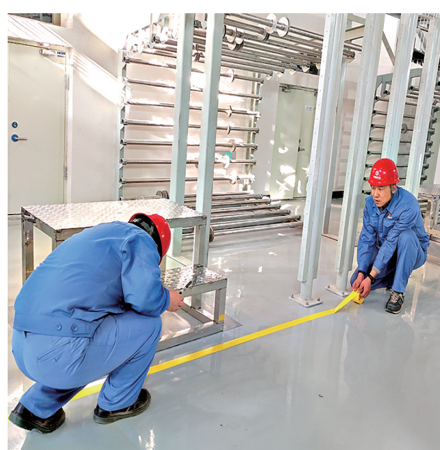
钢科公司新建三号生产线投产以来,新建各车间按照统一部署,统筹规划,持续整顿,从工器具定置管理、现场卫生清扫、现场标识完善等方面高标准做好5S管理,营造了清爽、整洁、安全、高效的工作环境。图为新车间职工正在设置现场标识。 王俊艳 摄
