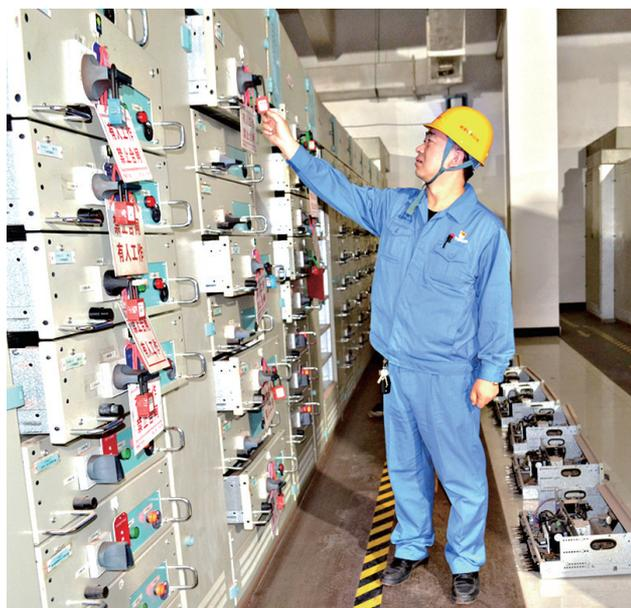
太钢岚县矿业公司牢固树立“安全第一”思想,严密现场安全管控,保证电气设备安全稳定运行。图为安全管理人员正在检查低压配电柜的上锁情况,为生产用电安全提供可靠电力保障。
