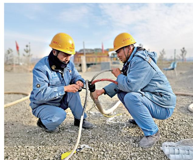
太钢尖山铁矿认真开展精细化、智能化点检活动,围绕设备缺陷隐患整改发动职工参与到设备改善管理中,不断提高岗位人员设备操控水平,用设备性能稳定保生产顺利进行。图为该矿职工正在制作电缆终端头。 郑磊 摄
