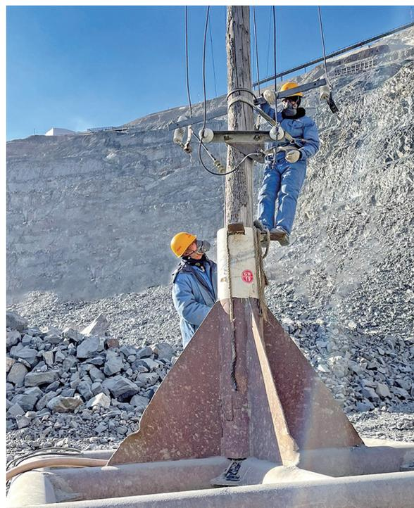
太钢尖山铁矿持续强化安全红线意识和底线思维,开展全方位的安全风险隐患大排查大整治,确保排查全覆盖、风险隐患整治到位,实现安全受控。图为该矿采矿部对架空线路进行检查维护,确保输电线路安全可靠运行。公冶政荣 摄
