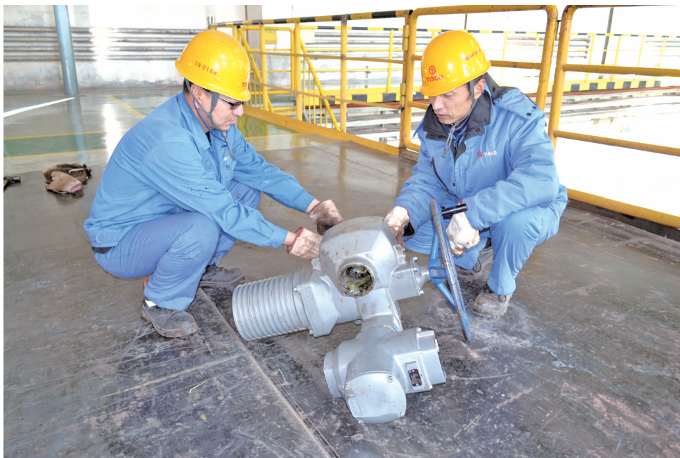
太钢岚县矿业公司在日常工作中严格按照安全技术规范要求,做好设备检查和维护保养,加强隐患排查整改,杜绝设备“带病工作”,以达到设备使用寿命长、综合效能高和连续安全生产的目的。图为职工正在维护磨矿环水泵进料阀门电动头。 康莹摄
