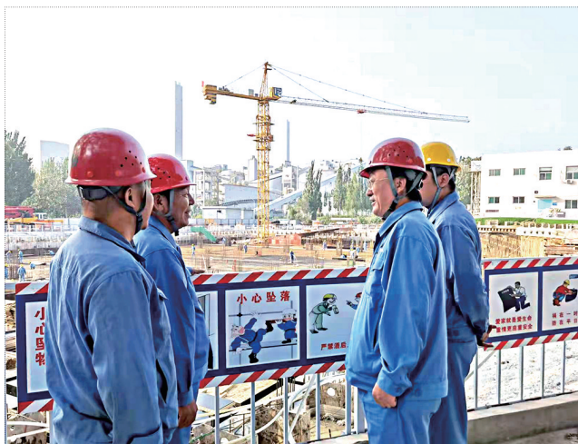
太钢工程技术公司党委深入贯彻落实习近平总书记“党政同责、一岗双责、齐抓共管”的指示精神,扎实开展“强党建、促安全”专项行动,进一步加强党对安全生产工作的领导,充分发挥党组织把方向、管大局、促落实作用,坚持服务生产经营不偏离。该公司全体领导班子成员和纪委安全督查组到智慧生产管控中心、冷轧智控大楼项目、岚县碱性球团等太钢重点工程项目,开展安全评价检查和安全专项督查,扎实推动安全生产责任制落实到位。图为安全检查和督察现场。 苏勇摄
