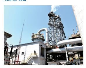
炼钢二厂北区3号转炉混合湿电除尘项目2021年11月10日动工,2022年5月13日建成投用并稳定运行。该项目是在北区3号转炉一次干法除尘系统后增加1台混合湿电除尘设备(包括煤气冷却器),与前部干法除尘相耦合,双管齐下,使转炉烟气除尘、煤气净化能力大幅提升,烟气排放浓度远优于超低排放要求标准,且实现了转炉煤气品质的再提升。
