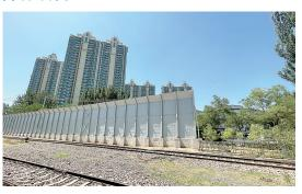
为进一步降低铁路噪声对沿线住宅小区的影响,物流中心在炼钢一厂铁路西侧建设了长150米,高6米的声障屏,有效阻断了机车运行对附近恒大名都小区的噪声影响。同时使用新技术铺设轨道,并加强线路维护、车辆保养、定期检修钢轨及车轮,减轻轮轨摩擦产生的噪音。在管理上要求机车在进入噪声敏感、建筑物集中区域时缓速慢行、禁止鸣笛,多举措最大限度降低噪声对外界环境的影响。此外,太钢还对重点噪声源设备设施进行消音改造,部分生产环节进行封闭治理,重点部位加增隔声屏,敏感区域禁止夜间施工等来降低噪声污染,通过开展"静音"行动,多举措防噪降噪治噪,还居民以宁静和谐美好的人居环境,为钢企与城市共生共融树立了环保新典范。
