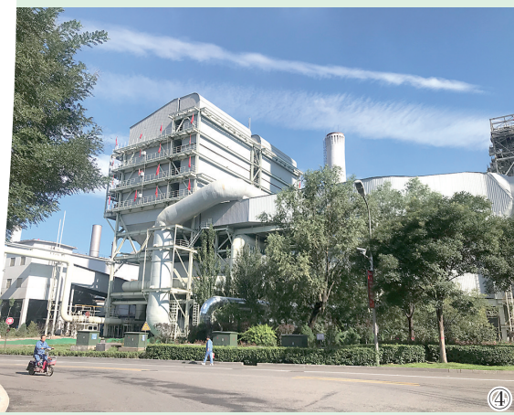
图①：运行中心外景。图②：运行中心内景。图③：太钢焦化厂。图④：炼铁烧结工序。图⑤：碳循环示范园。
