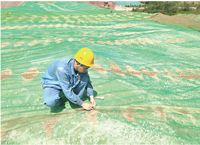
太钢复合材料厂围绕“绿水青山，节能增效”主题，对厂内存在的环保问题进行自查自纠，并要求区域负责人高标准严要求进行整改落实。图为作业人员对自己承包粉矿料堆区域进行抑尘网覆盖。 杨帆 摄
