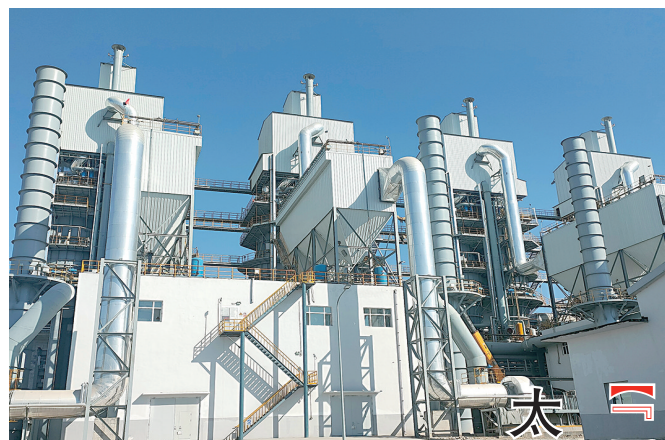
图为新建石灰窑外景。
