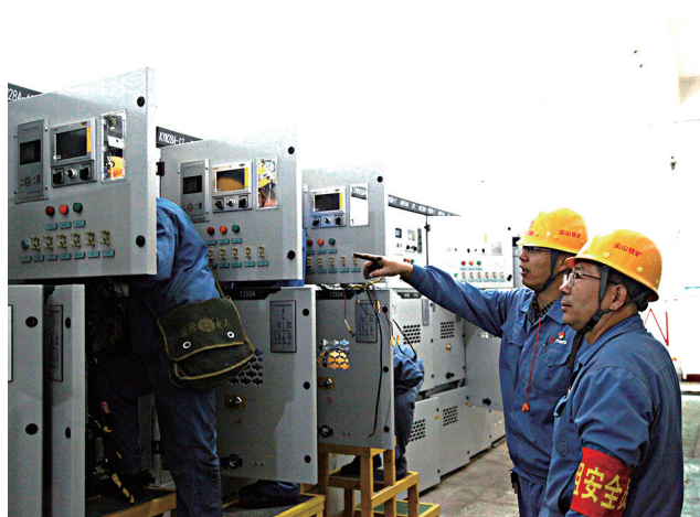
太钢尖山铁矿坚持现场分级管控,按照作业危险程度,完善现场安全分级管控,明确各项作业的管控人员和职责,强化逐级监督,完善惩处机制,切实保障现场作业人员的安全。图为现场管理人员对维检作业进行监督。郭旭壮 摄
