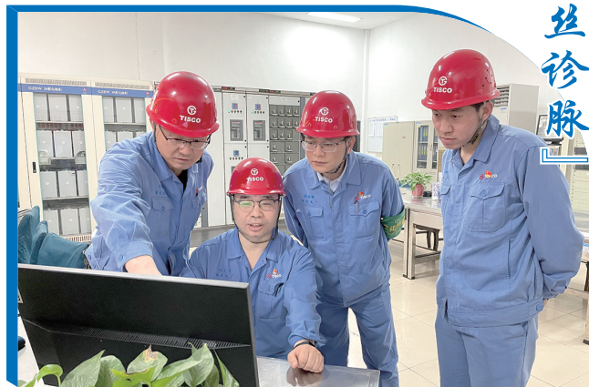
图为设备能源室职工通过新系统检测辊道运行情况。
