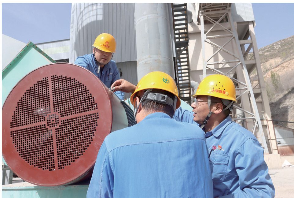
太钢鑫磊公司积极践行“两于一入”理念,加强环保设施检查,确保环保设施投运正常,环境治理设施与主体生产设施同步检修、同步运行,同步运转率100%。图为回转窑作业区职工正在维护除尘器。 李悦 摄
