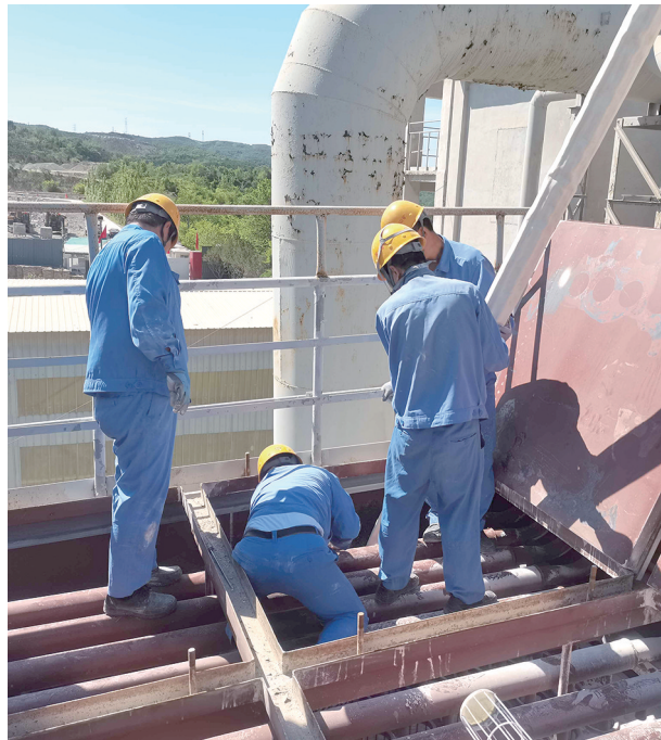
为深入贯彻落实应急减排工作，太钢东山矿制粉事业部积极行动，多措并举，绿色发展水平持续提升。图为岗位人员正在检查更换除尘袋。徐丽玲 摄
