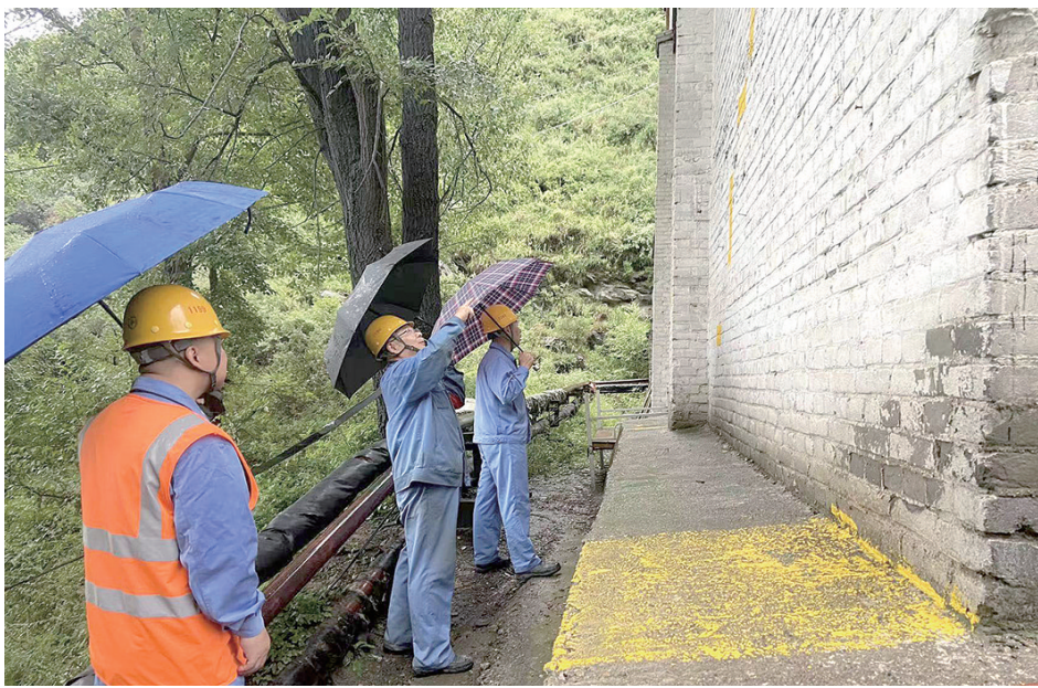
进入汛期,太钢代县智维中心检修一队管理人员冒着大雨对厂房周围边坡、建筑物、沟渠排水系统进行隐患排查,发现问题及时组织整改,确保人员、设备设施安全。
