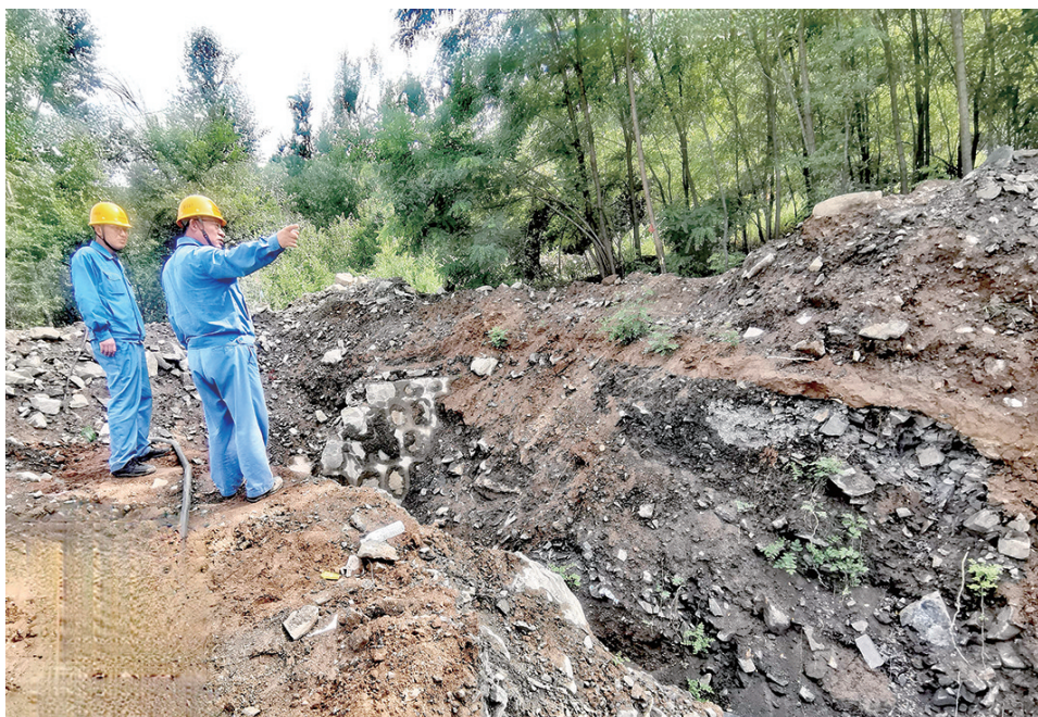
太钢尖山铁矿成品动力部重视防汛工作,密切关注降雨变化,对精矿管道、尾矿管道沿线重点防护管段加密巡护频次,重点查看主要河流水位变化情况,防止管道出现冲沟、水毁等情况。 王晋仁 摄 郑惠文
