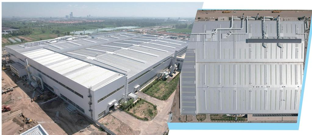
本报讯(通讯员 赵谦 刘治宏)近日,太重集团高端装备产业园区正式投产,该项目热加工车间15万平方米工业厂房选用太钢长寿命、免维护、绿色环保型TJ12建筑用不锈钢产品作为其金属屋面,该项目的成功应用成为太钢建筑用不锈钢在工业建筑领域围护系统技术引领、消费升级的又一典型项目。
