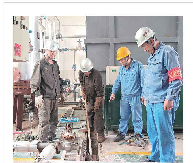
为建设采选工业园区花园式厂区,近日,太钢代县矿业公司对采选锅炉房污水处理器排放系统破损管道进行更换处理。图为清理更换场景。
