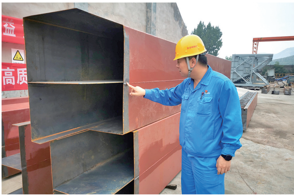
太钢复合材料厂紧抓工程项目质量管控,发挥三方合署、日管控、专业联检及专检作用,从材料进场、隐蔽验收、施工作业各环节做好管理监督,确保工程质量满足设计及建设规范要求。图为主管人员对进场管道进行查验。 闫慧娟 摄
