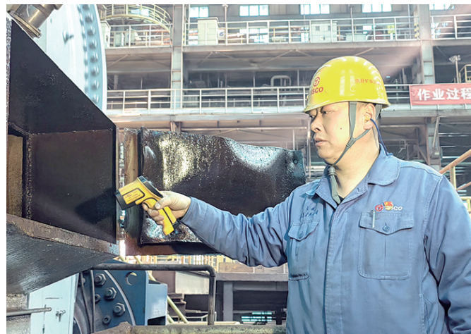
太钢岚县矿业公司持续推进标准化建设,强化设备专职工点检,运用小神探点检系统,全面推进设备管理信息化建设,有效降低设备故障率。图为职工正在点检设备。 牛玉凤 摄
