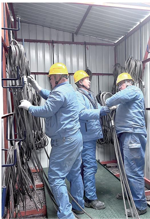
近日，太钢东山智维中心按照点检标准对现场钢丝绳进行检查，并对不符合标准的钢丝绳进行割断和报废，确保现场作业时使用的钢丝绳全部完好，保证检修作业安全受控。
