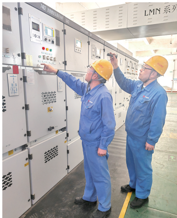
近日,太钢尖山铁矿开展电气安全专项整治,完善电气安全管理体系,抓好电气安全职责落实,全面排查并消除电气设备设施的安全隐患和电气作业的不安全行为,防止触电伤害、电气火灾等事故的发生。图为电工对高压柜进行点检。 王科举 摄 陈小革 文
