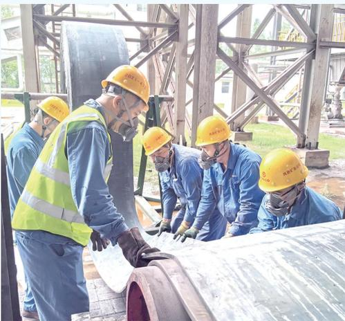
太钢岚县矿业公司球团二线年度检修覆盖了宽皮带更换、传动链齿更换、链篦机余热利用安装、脱硫吸收塔防腐修复等关键领域,共计涉及703项具体检修项目。每一项检修力求在保证安全的前提下,实现检修质量与效率的双重提升。通过此次年检,进一步优化生产流程,提升设备效能,确保生产的稳定运行与高效输出。
