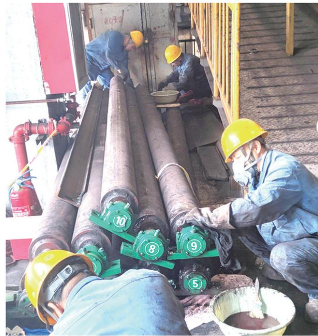
今年以来,地勘公司(智维中心)重点从检修现场管控入手提升“保姆式”服务质量,持续为各大矿山开展检修服务,不断巩固检修质量品牌优势。图为东山智维中心职工首次更换宽度4.5米的岚县矿业公司球团部二线作业区下料宽皮带,现场清洗拆下的托辊轴承座,还设备本色。
