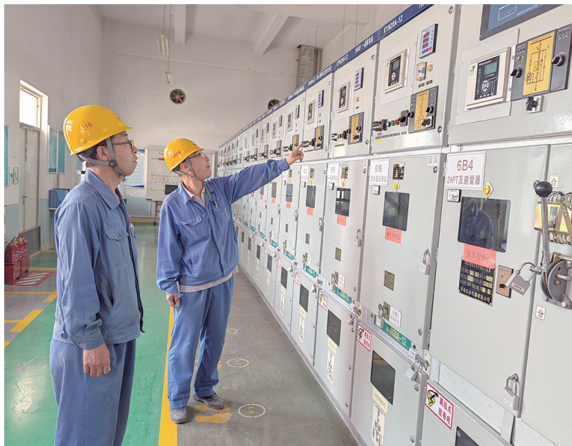
为确保电力系统的安全稳定运行,东山智维中心增加电工岗位的电气设备巡检频次,巡视电线电缆是否完好、接头有无松动,检查线路、电源是否正常,设备风扇是否散热正常,重点关注发电机、变压器、电动机等关键设备的温度、油温、油位变化情况。图为两名电工在2破高压室进行巡检。 康玉梅 摄
