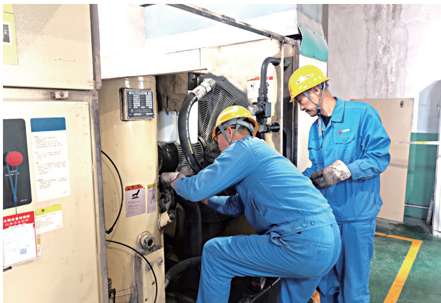
冬季采暖稳运行，设备维保要先行。复合材料厂家属区采暖采用回转窑余热利用供暖方式，为确保冬季采暖系统平稳运行，让职工及家属过上暖冬，该厂利用生产间隙，在采暖期来临前，对回转窑关键设备进行维保，确保冬季平稳运行。图为维修技术人员正在对空压机进行系统性维护保养。
