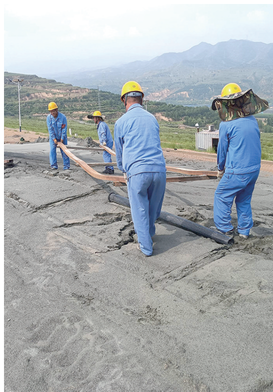
太钢尖山铁矿成品动力部抓住当前有利时机,对正常运行的城东沟尾矿坝进行子坝堆筑,避免极端天气对筑坝的不利影响,确保城东沟尾矿库安全生产。 张小云 摄 郑惠文
