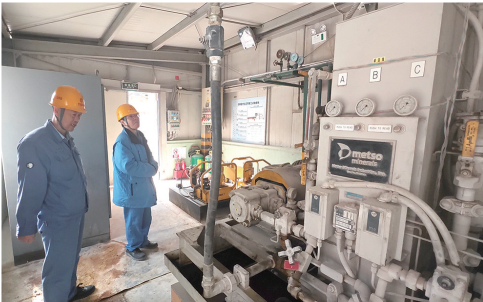
消防宣传月期间,东山矿全面启动消防安全专项活动,对重点区域展开拉网式检查,排查是否存在消防安全隐患,灭火器材是否过期,人员是否熟练掌握防火技能等内容。各单位也积极展开自查堵塞消防漏洞,补齐问题短板,筑牢消防安全坚固防线。图为专业人员检查现场。 高爱忠 摄
