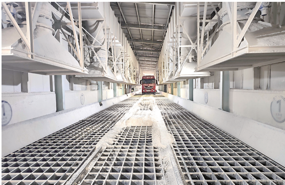
为全面完成生产经营预算指标,东山矿积极组织成品作业区收料坑改造,实现多车同时卸灰。与此同时,抽调人员指挥卸车,为安全、有序、高效作业提供了有力保障。图为收料坑改造完成通车场景。 刘婷婷 摄
